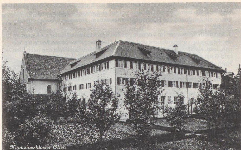
Abb. 11 Das Kloster nach der Aufstockung von 1932 (PAL FA I 28, 6)
