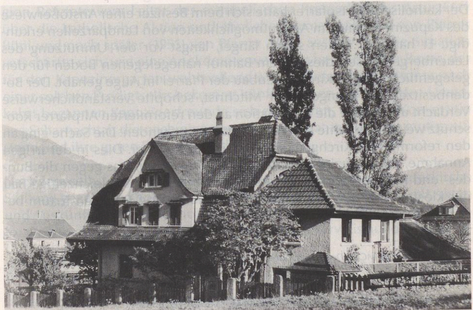
Abb. 5: Rückseite Kapuzinerheim Spiez 1945, darauf rechts erkenntbar der Anbau, umfunktioniert zur Hauskapelle. (Bild Ambros Marchesi OFM Cap , PAL)
