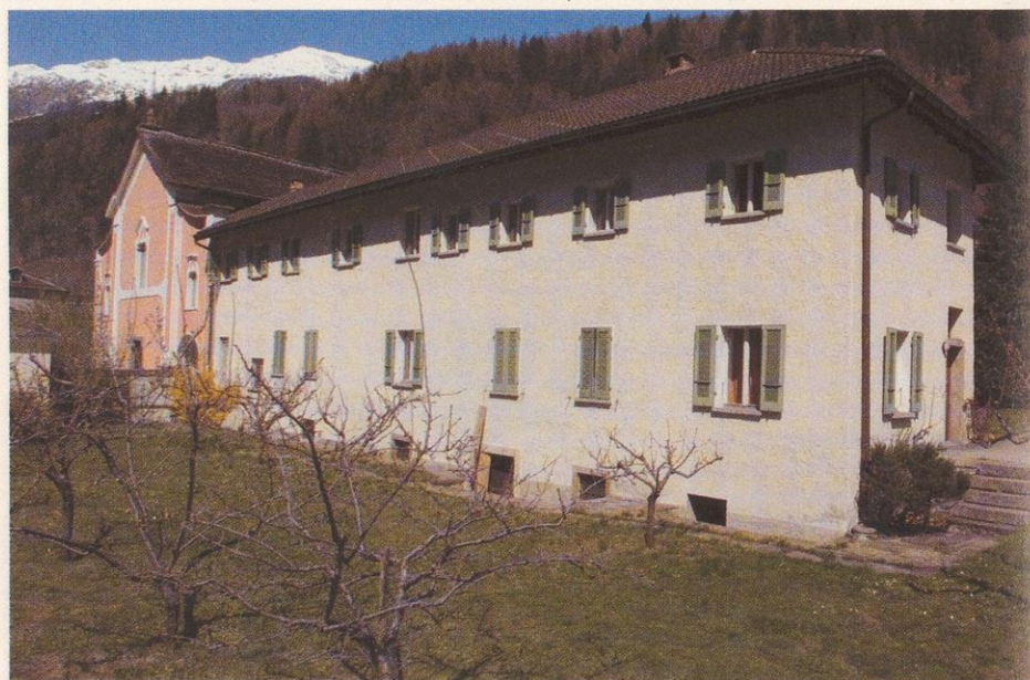
III, 10: Il Convento: facciata sud (foto: Bruno Fäh OFMCap)
