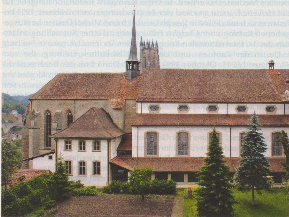
Abb. 14: Klosterkirche mit gotischem Chor, «neuer Sakristei» und barockem Schiff nach der Außenrestaurierung (©: Corinne Aeberhard; ACCFribourg)
