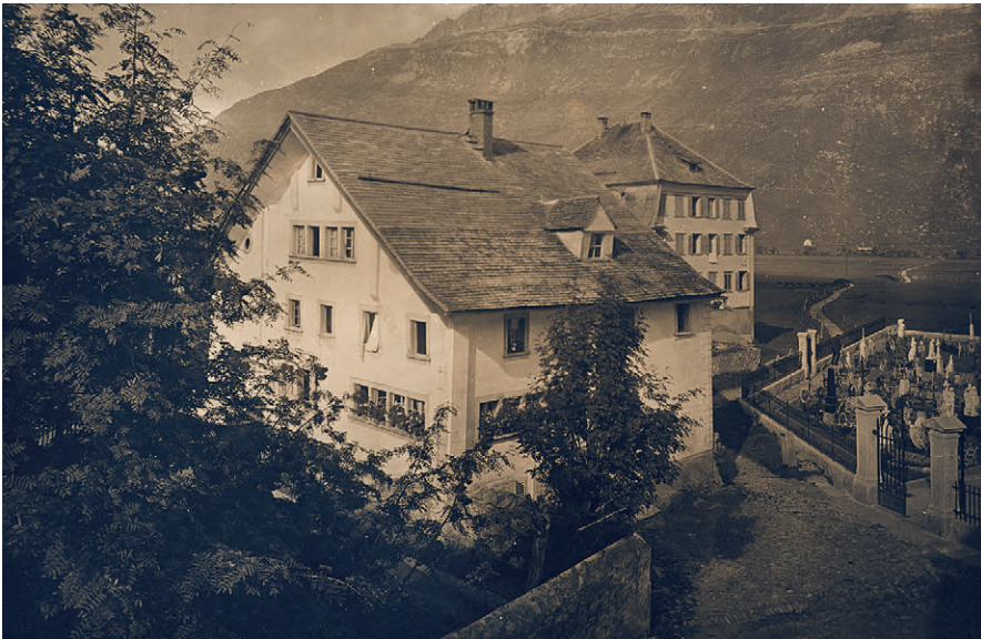
Abb. 7: Das alte Hospiz Andermatt, das als Pfarrhaus diente, bis zum Abriss 1912 für ein neues Hospiz (PAL FA I Andermatt)
