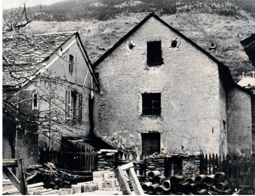
Abb. 1: Reste des zuletzt als Baudepot genutzten ersten Kapuzinerklosters in Brig von 1659, Ende Achtzigerjahre des 20. Jahrhunderts abgerissen (© PAL Ikonothek)
