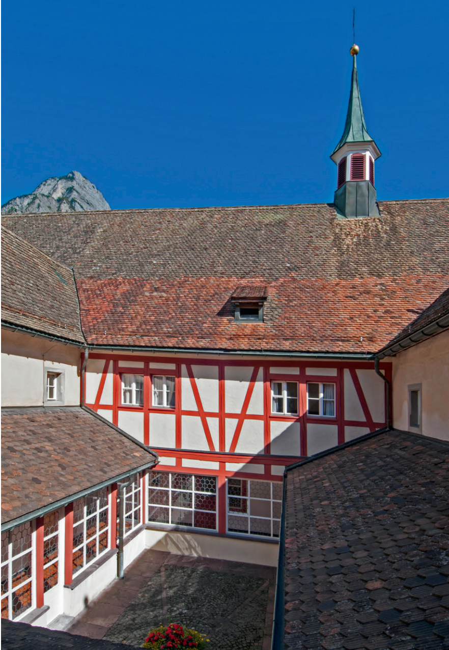
Abb. 4: Der Innenhof mit Blick zur Kirchendach und Dachreiter und dem vorgelagerten Riegelbau. (Photo: Menga von Sprecher, Maienfeld)
